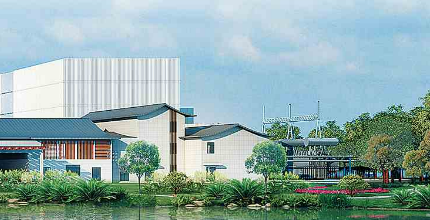
建设中的江苏吴中智慧园区 魏静松 摄
