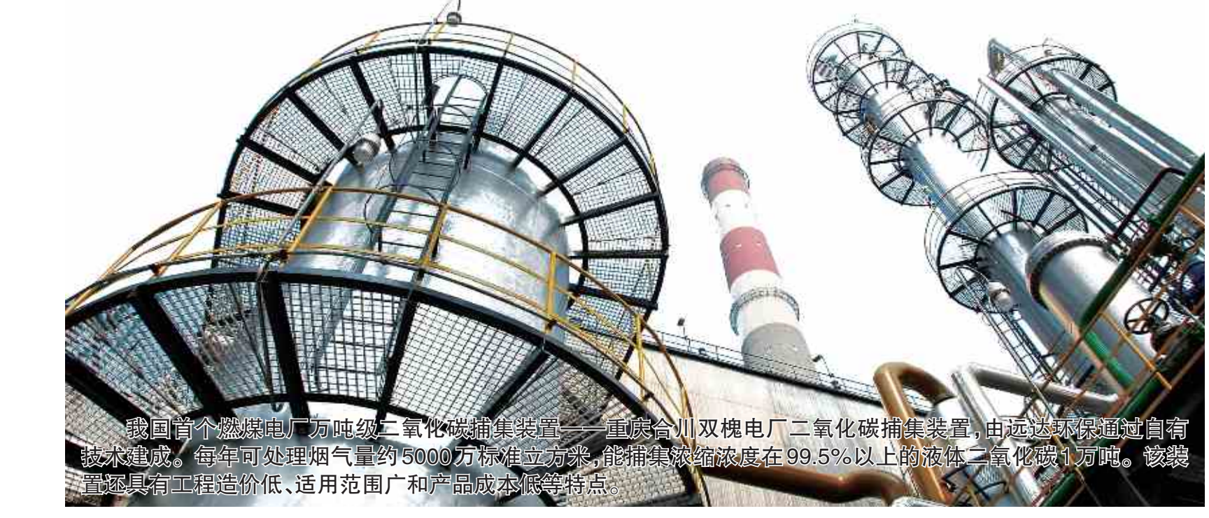
我国首个燃煤电厂万吨级二氧化碳捕集装置——重庆合川双槐电厂二氧化碳捕集装置,由远达环保通过自有技术建成。每年可处理烟烟气量约5000万标准立方米,能捕集二氧化碳浓度在99.5%以上的液体二氧化碳1万吨。装置具有工程造价低、适用范围广和产品成本低等特点。
