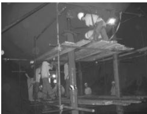
主支撑加垫处理(定子及泡头顶起)
