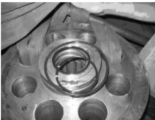
桨叶窜油处理(拆卸的活塞杆及密封)
