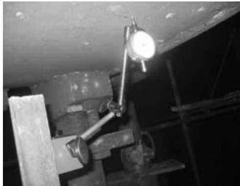
主支撑加垫处理(定子位移量监测)
