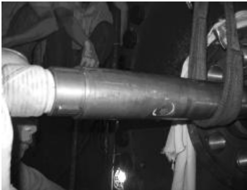
窜油处理(活塞杆压盖拆卸后)
