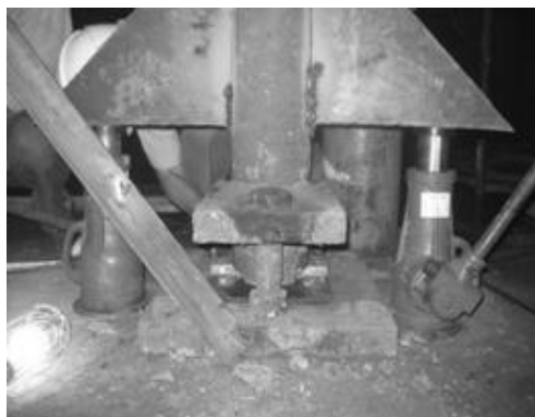
主支撑加垫处理(主支撑顶起并加紫铜垫)
