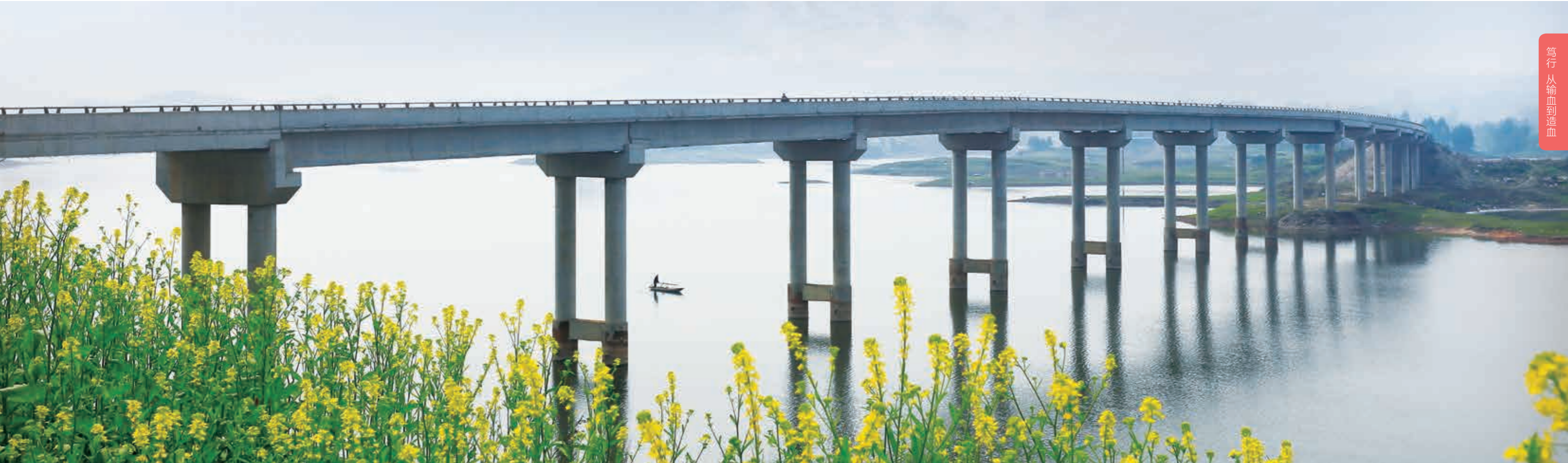
重庆狮子滩发电公司大洪河电站水库上的桥梁 ▲
