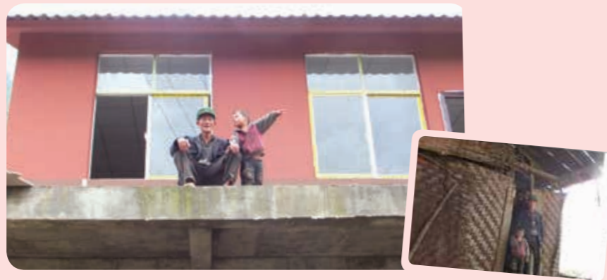
» 国家电投云南国际在云南泸水县修建“轻钢房”，让村民住上了放心房
