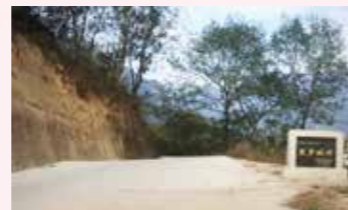
在商城县修建里罗城路
