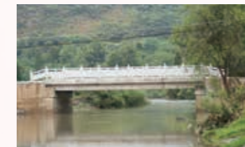
街上村桥梁建设
